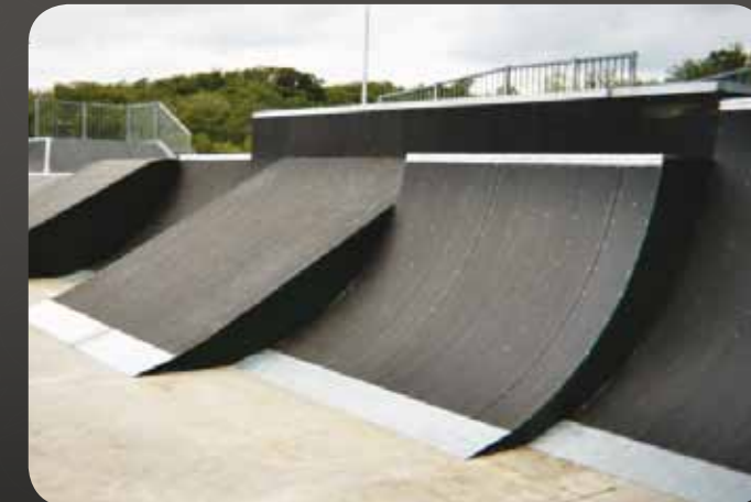
LATERALES Y GABINETES DE POLIETILENO DE 3/4" HD
